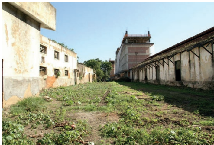
Figura 2 – Área externa do Galpão.
